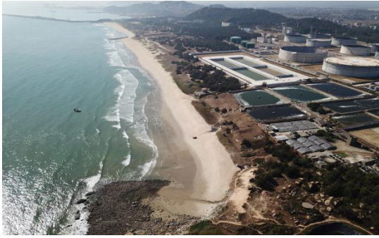
图 6 茂名市电城镇马槛村东南面岸段
